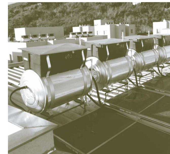
de água quente para cada unidade familiar. A condução da água até o ponto de consumo de cada apartamento foi realizada por gravidade, dispensando a eletricidade, e em tubulações específicas para água quente.
